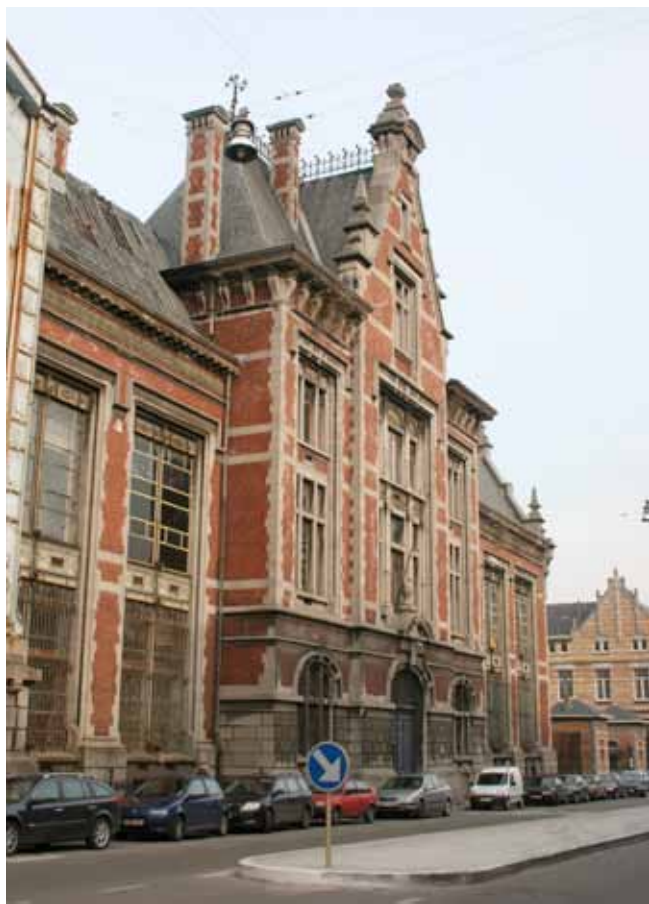
Façade actuelle de l'Hotel d'administration rue Picard, 2008.
