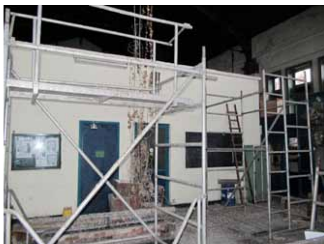
Vue intérieur depuis l'entrée, 2010.
