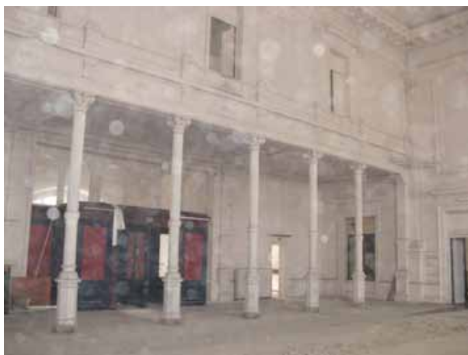
Vue actuelle vers les colonnes en fonte, 2006.
