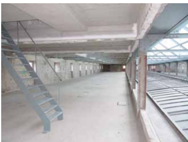
Sous-toiture rénovée, au niveau de la verrière, perspective côté du site et canal. La double verrière est bien visible, la rénovation a retiré les cloisonnements, 2010.
