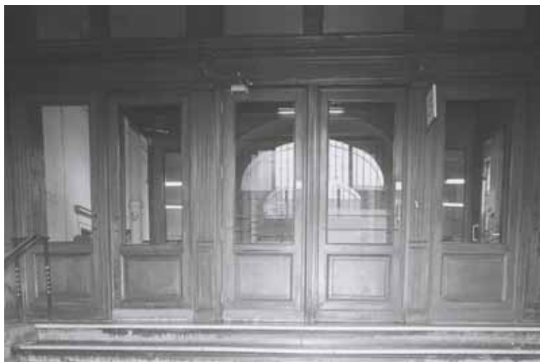
Haut de l'escalier vers sas en chêne vernis, 2011.
