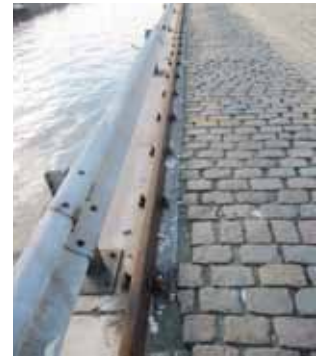
Rails pour les grues du quai des matériaux, face à Thome-Ghémar.
