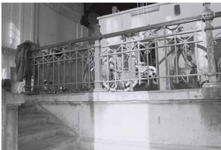
Escalier d'accès et balustre. Munoz 03/93, fonds la Fonderie.
