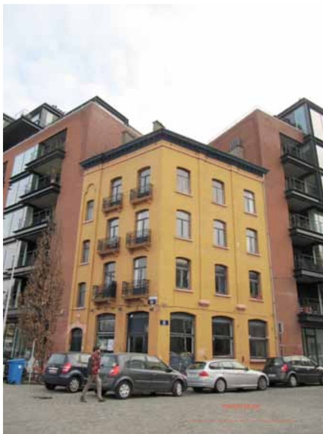
Vue depuis la quai aux matériaux du coin rue de la Dyle et quai des Péniches.
