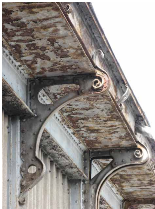
Détail des corbeaux de corniches de la gare, 2006.
