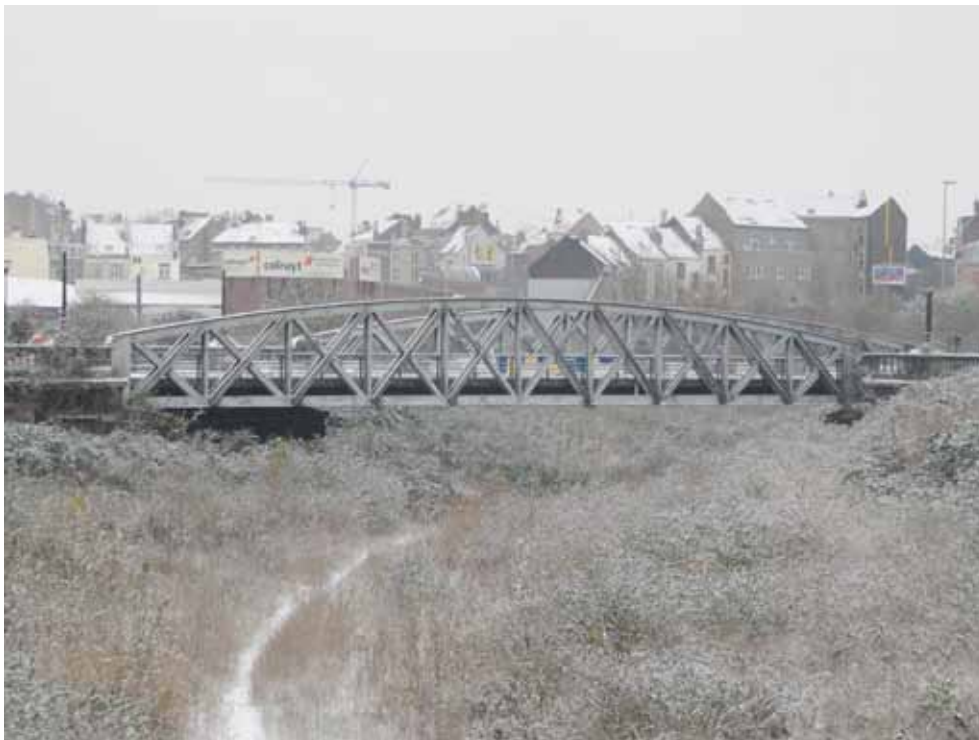
Le pont de la rue Clesse-Dubrucq depuis le pont monumental.
