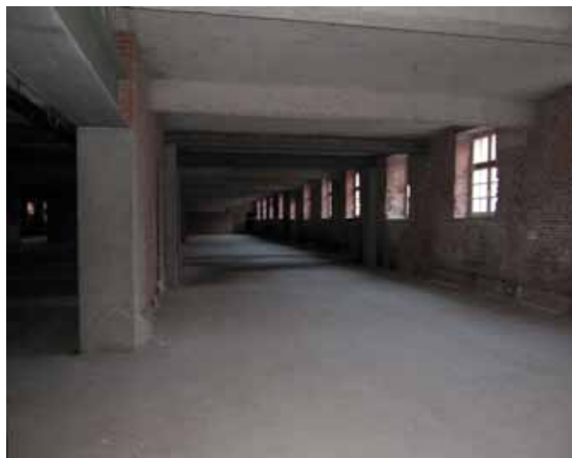
Sous-sol en cave vers le site, toutes les anciennes fonctions ont été enlevées. Un accès voiture pour vingt parkings a été aménagé, 2010.
