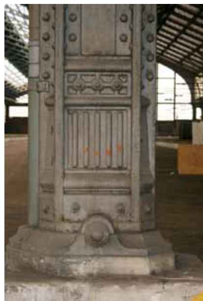
Pied d'une des fermes supportant les toitures, l'axe de rotation est bien visible, 2008.
