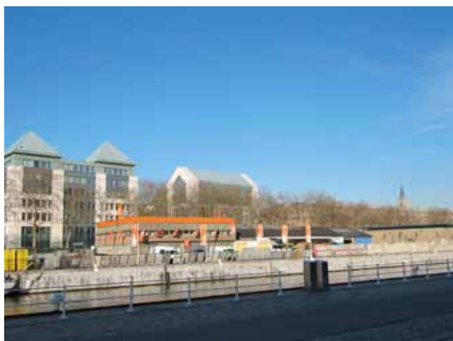
Magasins vu depuis le quai des Péniches en face.
