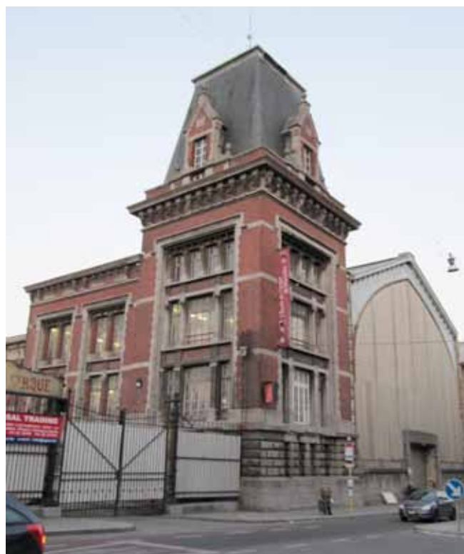
Tour carrée en prolongation des façades de la rue Picard, 2010.
