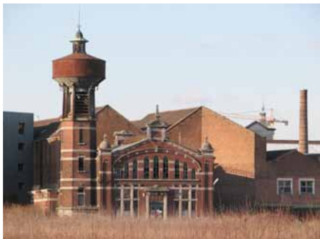
Vue actuelle du château d'eau et cabine de haute tension, 2004.
