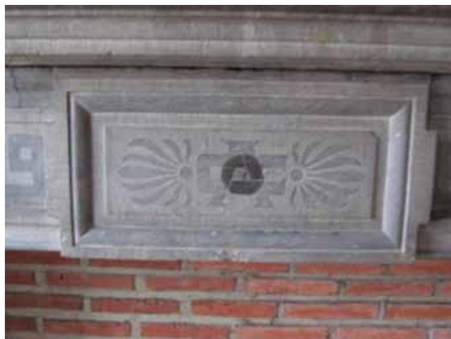
Détail central de cette cheminée.
