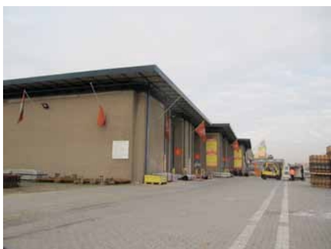
Extérieur des nouveaux magasins MPRO3 sur le quai des Matériaux vers la place des Armateurs.
