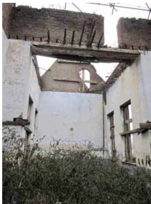
Vue intérieure actuelle de la Chapelle, 2010.
