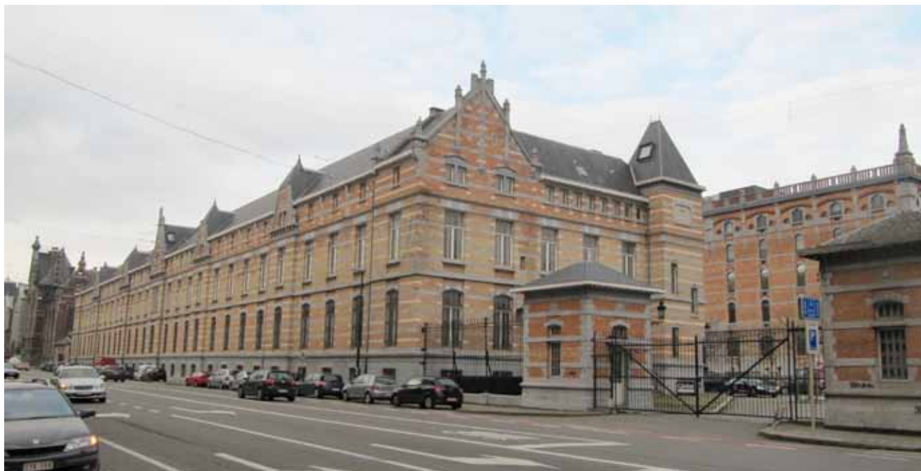
Façade de l'Hôtel sur la rue Picard, avec ses aubettes, 2011.
