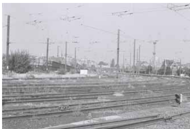
Voies grilles vers chapelle et pont. Munoz 07/90, fonds La Fonderie.
