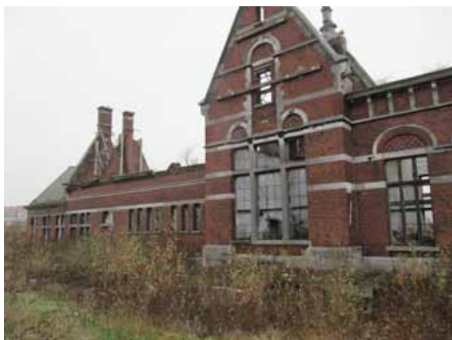
Vue actuelle depuis le site, vers le T.I.R., 2010.
