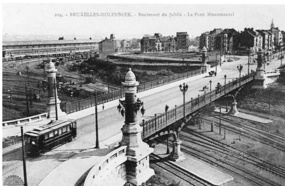
Carte postale : Le pont Monumental complet, vers la Gare de Tour & Taxis.
