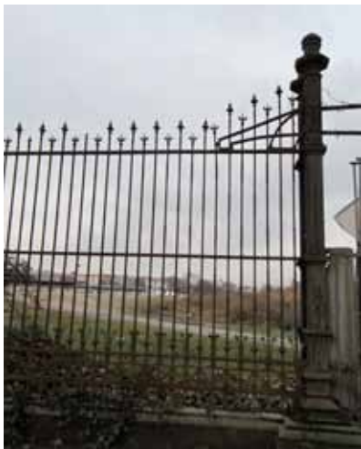
Réalité actuelle de ce montant d'entrée, avenue du Port, 2008.
