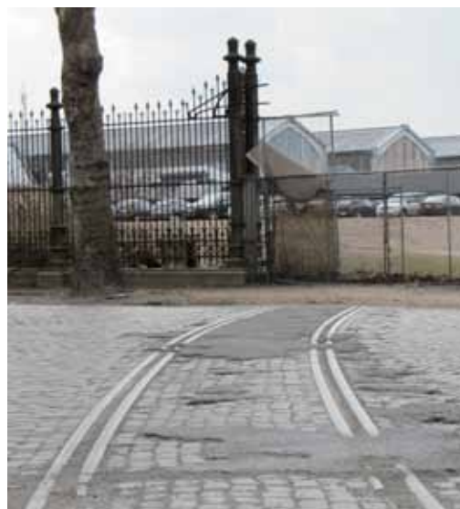
Voie ferrée traversant l'avenue du Port, reliant le site de T&T aux quais du bassin Vergote, 2008.
