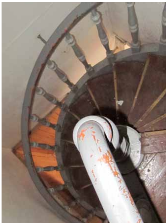
Escalier colimaçon dans le « Thomé » du quai des matériaux.
