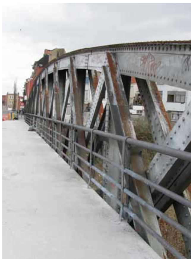
Une structure du pont Clesse.
