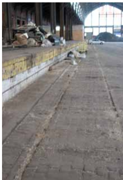
Voie ferrée le long d'un quai vers arrière, 2008.
