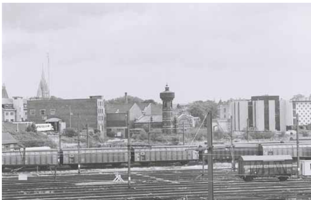
Château d'eau et cabine de haute tension avec les voies ferrées et les wagons. Munoz 03/93, fonds La Fonderie.
