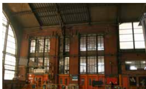
Façade depuis l'intérieur de la Gare, 2006.
