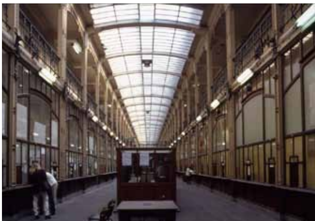
Vue axiale du rez-de-chaussée en activité. Chapel 10/98, fonds La Fonderie.
