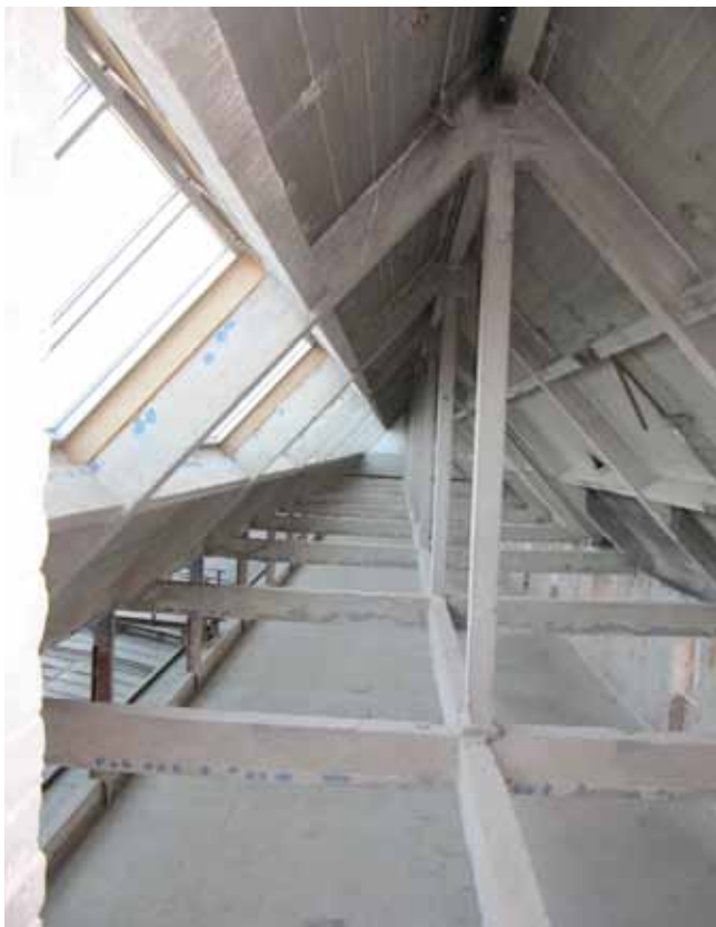
Les combles dégagés avec de nouveaux lanterneaux vers la verrière centrale, 2010.
