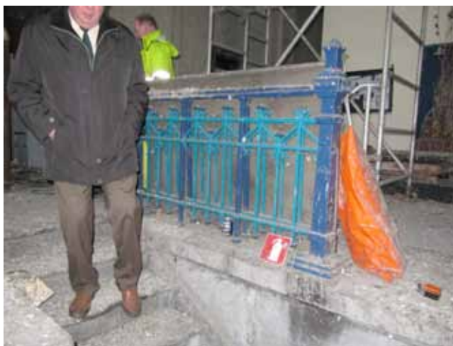
Balustre et escalier d'accès, actuels, 2010.
