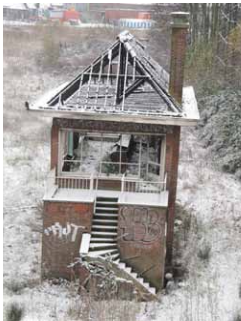
Zoom vue actuel depuis le site - à droite l'escalier extérieur d'accès, 2010.
