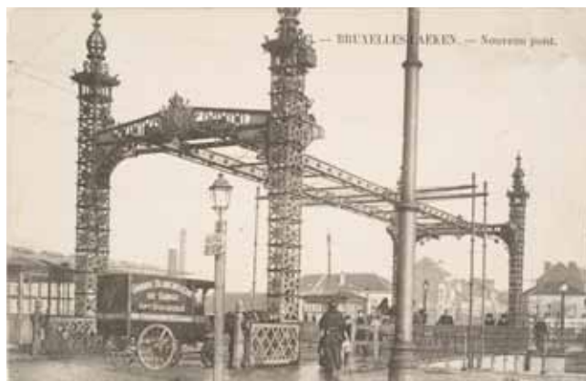
Carte postale du pont de Laeken en 1906 avec sa structure ouvragée de pont levant. Fonds DEXIA- Direction des Monuments et sites - Académie Royale de Belgique.
