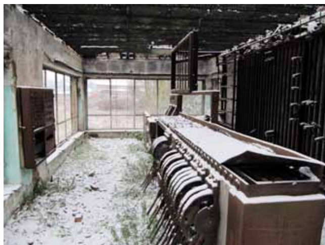
Vue actuelle de l'étage en entrant par l'escalier, 2010.
