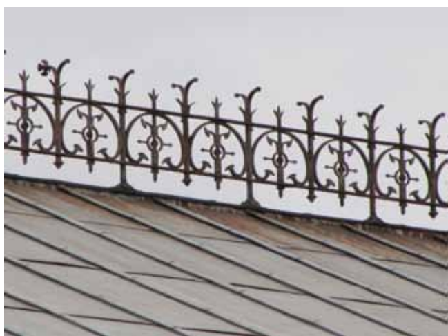
Frise faitière sur la toiture, 2010.
