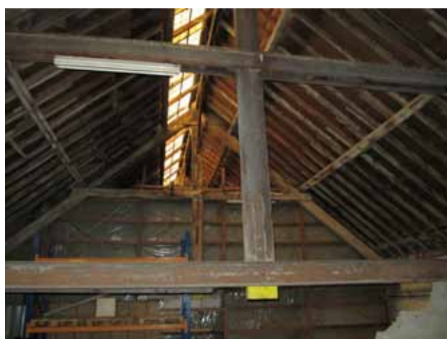
Une des charpentes de la partie centrale du Cereg-Thomé.
