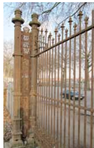
Pilastre en fonte actuel restant à l'avenue du Port vue depuis l'intérieur du site, 2011.
