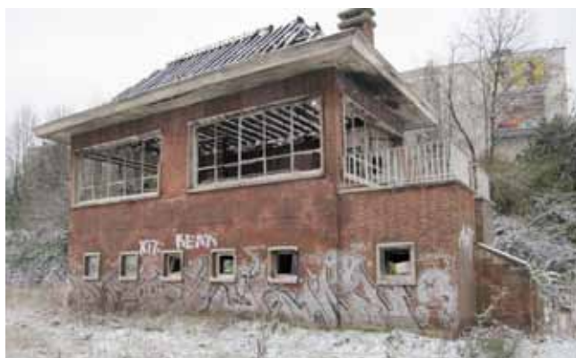
Façade actuelle depuis le site, 2010.
