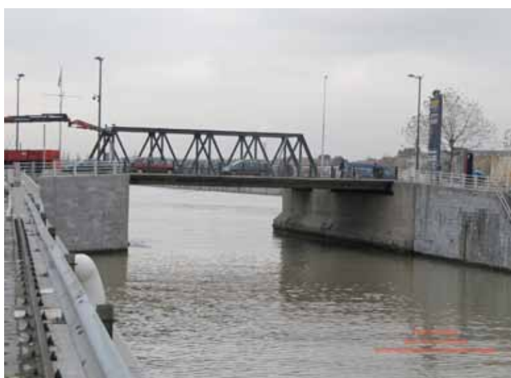
Vue actuelle du pont-rail de la place des Armateurs vers le bassin Vergote.
