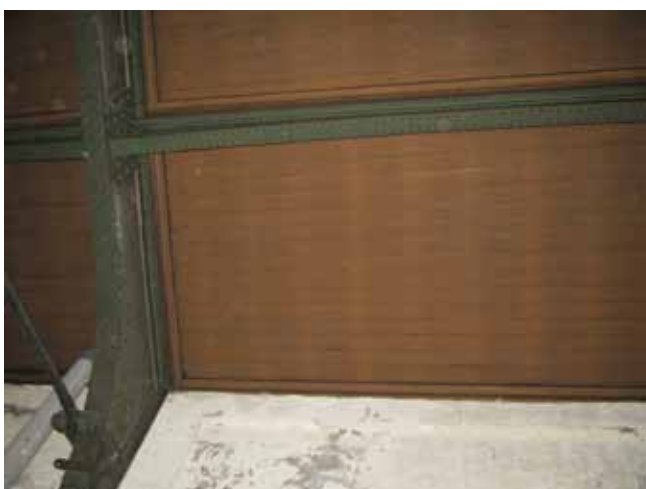
Plafond lambrisé et ferme rivetée, 2010.
