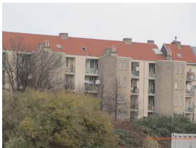
Vue arrière actuelle, depuis le site de T&T des logements sociaux de Saulnier, avec l'ajout des salles d'eau.
