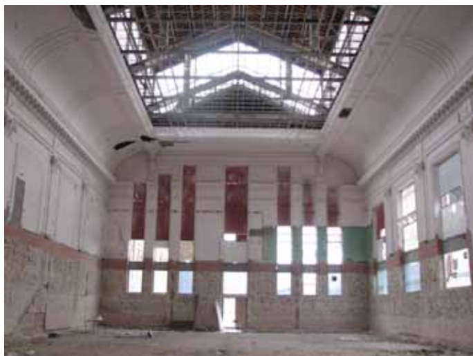
Vue du rez de chaussée de la salle, vers le site, la dalle de béton a été enlevée, 2007.
