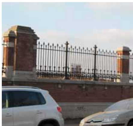
Piliers en briques et granit, avenue du Port, 2010.
