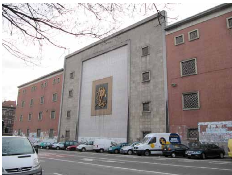
Façade du dépôt sur la rue Picard.
