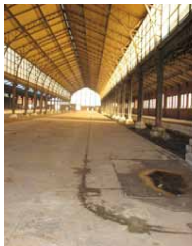
Vue axiale de la halle latérale vers sheds et site, avec système pour palettes, 2008.
