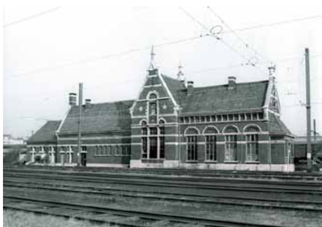
La gare de service appelée «la chapelle», 1975, archives SNCB à T&T.
