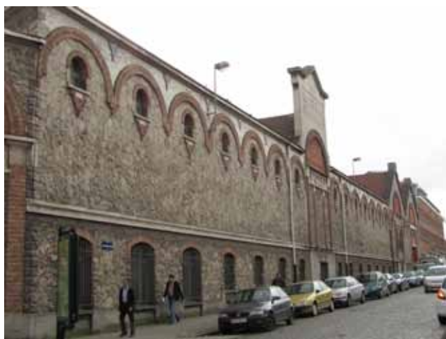
L'autre façade des anciens établissements BYRRH, rue Dieudonné Lefèbre.
