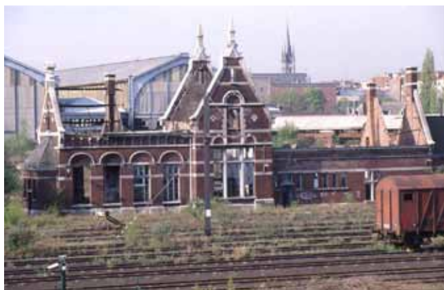
La Chapelle brûlée avec les voies et des wagons. Chapel 4/98, fonds La Fonderie.
