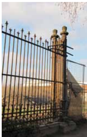
Pilastre en fonte actuel restant à l'avenue du Port, 2010.
