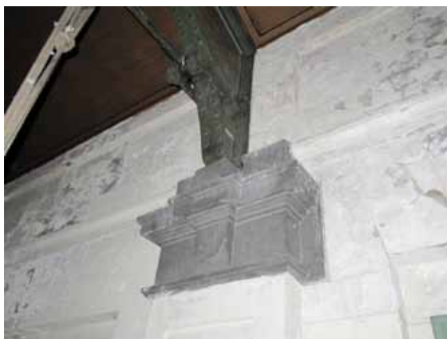
Console en pierre bleue pour une des fermes, 2010.
