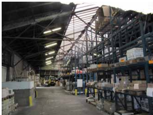
Intérieur de ce hangar.
