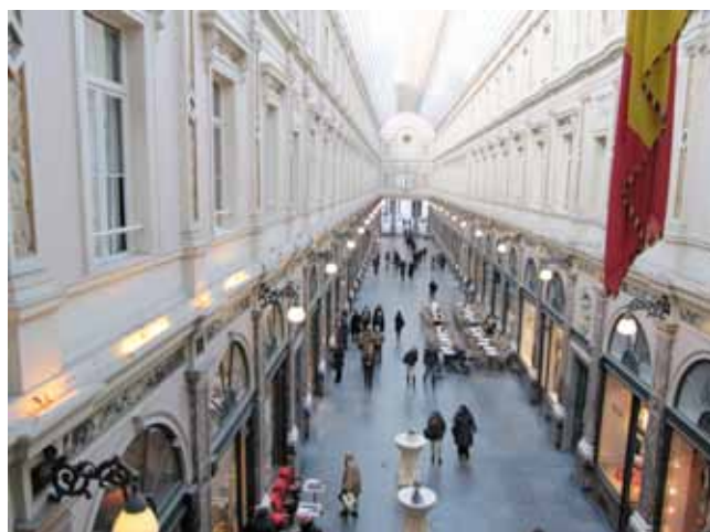
Vue plongeante de la galerie du Roi, 2010.
