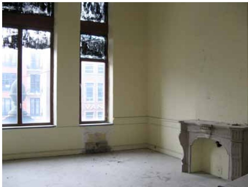
Bureau central du Directeur au 1 er étage avec cheminée de marbre, 2006.
