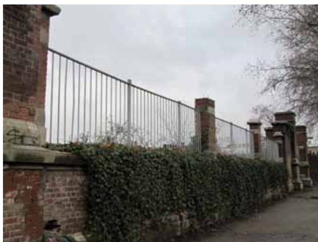
Grilles neuves avenue du Port,
