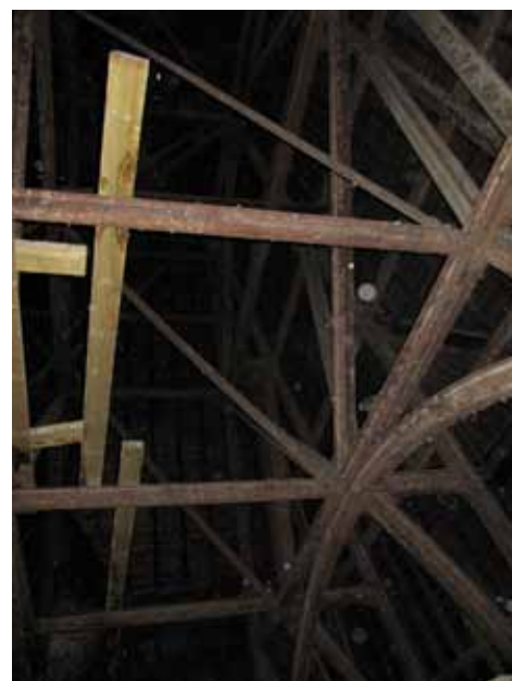
Charpente de la tour en métal rivetée, 2004.
