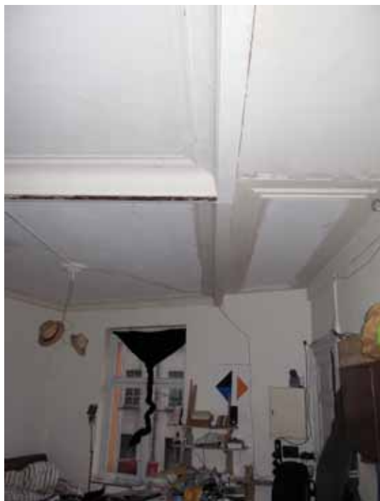
Plafond d'une pièce du 2d vers rue Dyle. L'on voit que des cloisons ont été enlevées.
