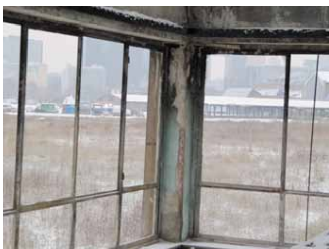
Vue vers site depuis l'intérieur de la cabine d'aiguillage, 2010.
