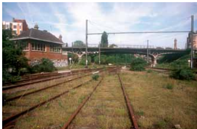
Voies vers la cabine et le pont. Munoz 09/97, fonds La Fonderie.
