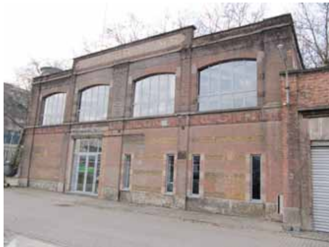
Façade du côté du quai des matériaux.
