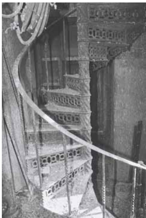
Escalier hélicoïdal dans la tour du château d'eau. Munoz 03/93, fonds la Fonderie.
