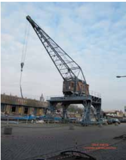
La grue SMET n°15, remontée sur le quai des péniches.
